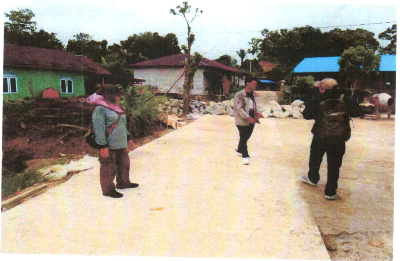
PEKERJAAN SEMENISASI JALAN 100% RT 19 POKMAS 1 SAMBUTAN
